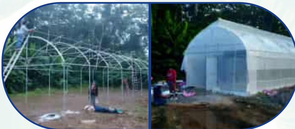
Figura 12. Construcción de invernadero de aclimatización
