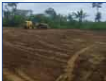
Figura 22. Nivelación de terreno para establecimiento de vivero de endurecimiento
