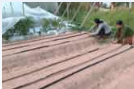
Figura 20. Instalación de riego por goteo en camas altas de cebolla en los predios del CNPSH, Sipe Sipe – Cochabamba.
