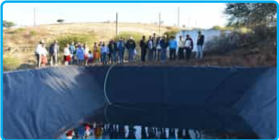
■ Reservorio de agua revestido con geomembrana Alto de Cajas – San Lorenzo
