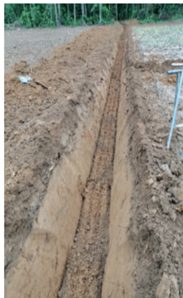
Figura 18. Apertura de canales de drenaje con tractor
