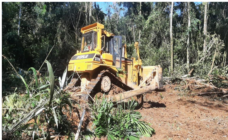
Figura 11. Habilitación de terreno usando tractor oruga
