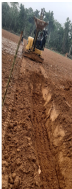
Figura 18. Apertura de canales de drenaje con tractor
