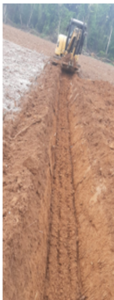
Figura 18. Apertura de canales de drenaje con tractor
